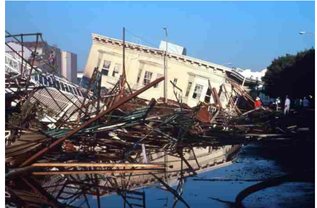
Prédios colapsados e queimados no Distrito de Marina, São Francisco. Loma Prieta, Califórnia, Terremoto de 17 de outubro de 1989.
