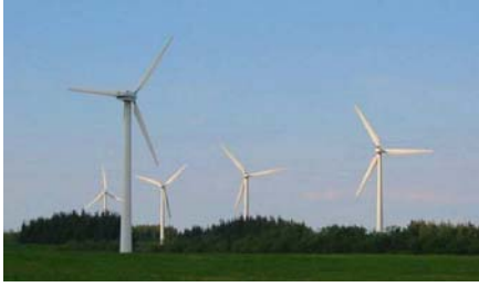
Turbinas eólicas Vendsyssel, Jutland, Dinamarca
