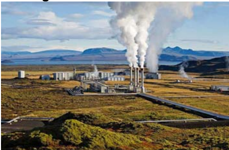
Usina geotermal de Nesjavellir, na Islândia
