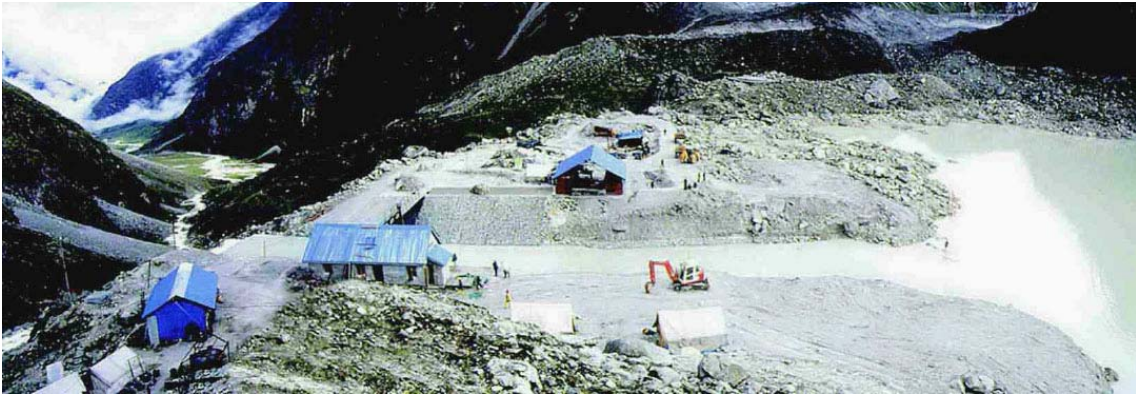
Um vertedouro e as comportas, construídos para controlar a descarga de água do lago represado pela morena Tsho Rolpa, Nepal (Foto: © RGSL 2009)
