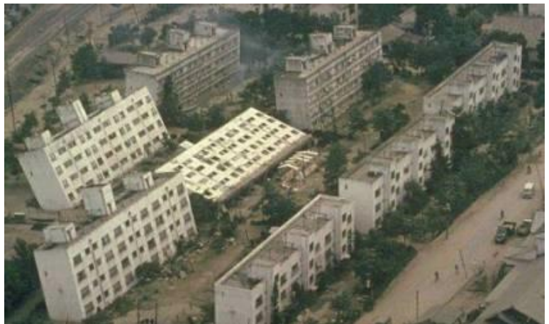
O que acontece com prédios sobre solo macio quando o terremoto ocorre.
