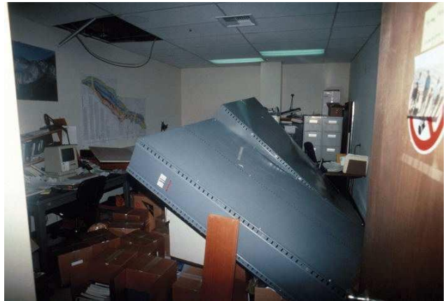
Estantes soltas no quartel genetal do USGS em Menlo park, California, o qual caiu durante o terremoto de Loma Prieta. Em 17 de Outubro de 1989. Slide VI-1 (Do Serviço Geológico dos EUA, http://libraryphoto.cr.usgs.gov Slide VI-1 USGS Open File Report 90-547)
