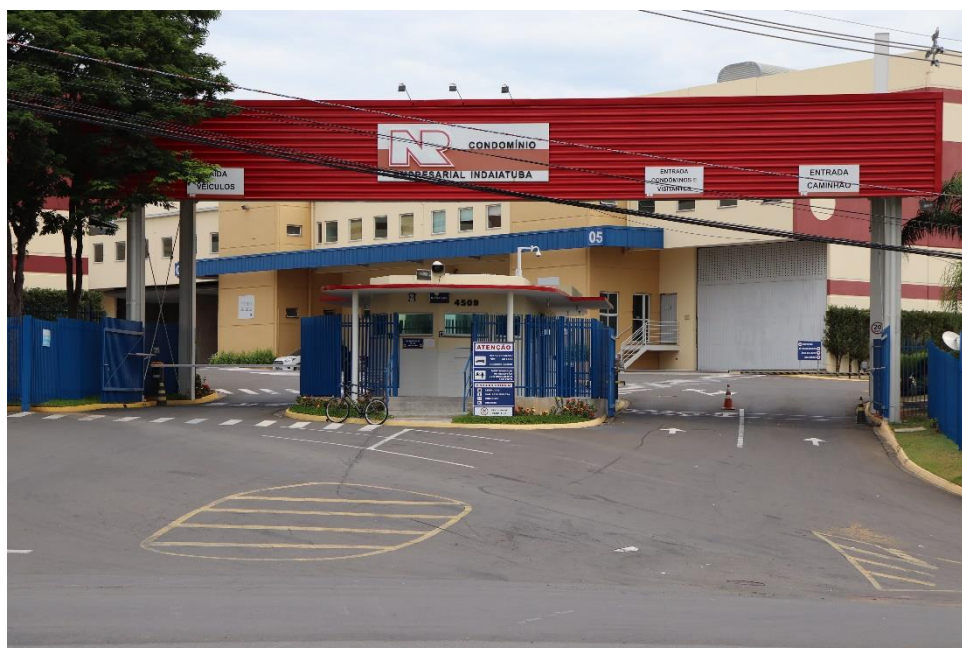
FIGURA 11 – CONDOMÍNIO INDUSTRIAL NR (INDAIATUBA)
