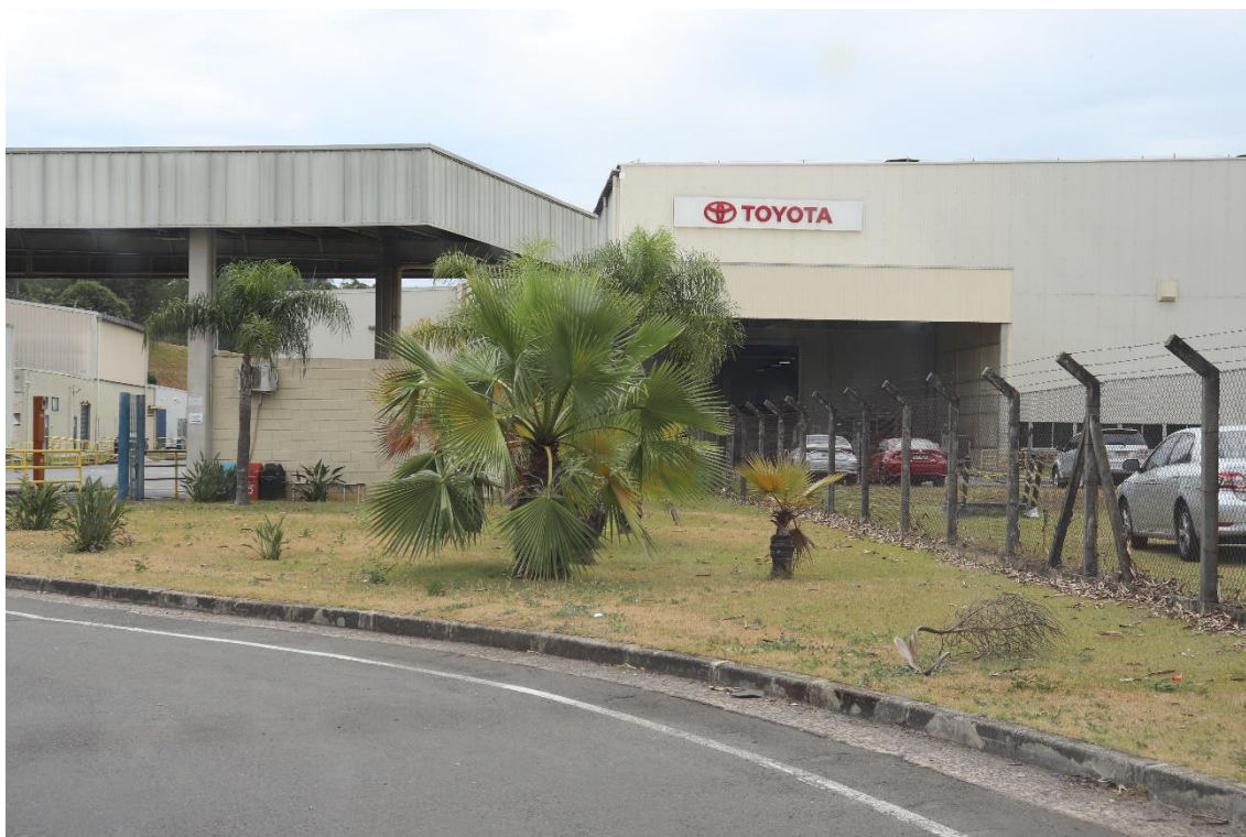
FIGURA 14 – FÁBRICA DA TOYOTA EM INDAIATUBA (RODOVIA SANTOS DUMMONT)
