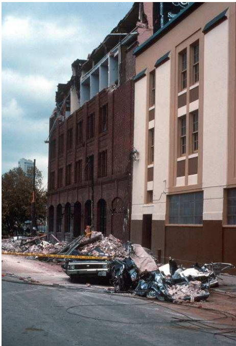
Carros esmagados pela queda de material de alvenaria, que matou 5 pessoas que deixavam o trabalho. Terremoto de Loma Prieta, 17 de outubro de 1989. (Foto: Serviço Geológico dos EUA, http://libraryphoto.cr.usgs.gov Slide 1-1 USGS Open File Report 90-547)
