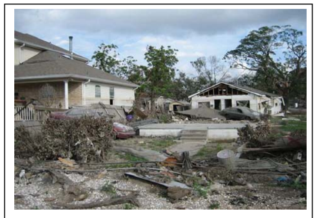
New Orleans após o furacão Katrina: a enchente danificou a vizinhança de West End, Belleaire Street. Águas da enchente arremessaram automóveis, que atingiram uma casa removendo-a de sua fundação e fazendo com que esta se movesse por meio quarteirão.
