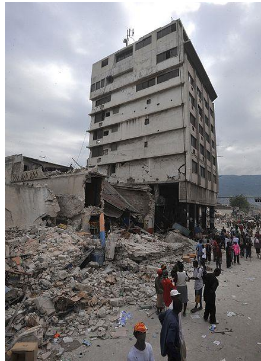
Edifícios danificados no bairro de Port-au-Prince of Bel-Air, após o terremoto de 2010 no Haiti. O bloco mais alto permanece de pé em meio às ruínas de prédios mais baixos, que não foram bem construídos.
