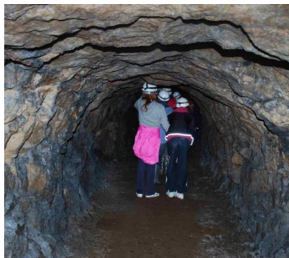
Um túnel sem escoramento no calcário, cavado por mineiros de cobre em 1804. (Todas as fotografias: Peter Kennett).
