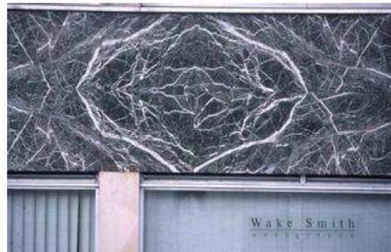
3. Serpentinite usado como uma rocha de fachada ornamental, (Sheffield)
