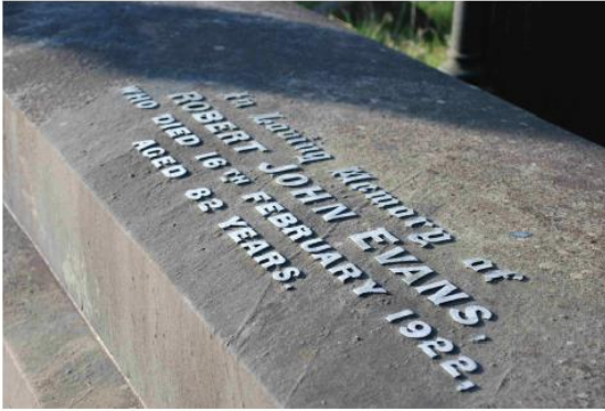
4 Uma sepultura de mármore, com letras de chumbo, uma vez nivelada com a superfície, agora com um desnível de 2,5 mm, Ecclesall Adro, Sheffield
