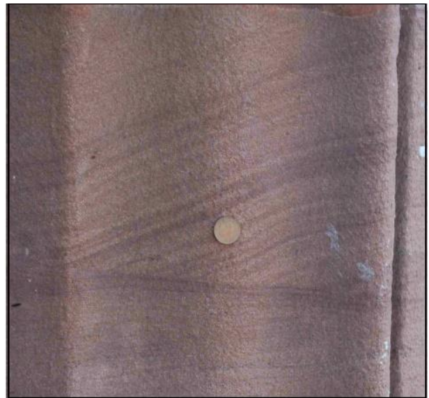
Fotografia 4: arenito vermelho na frente de um edifício (Moeda = 2cm) (Foto: Peter Kennett)
