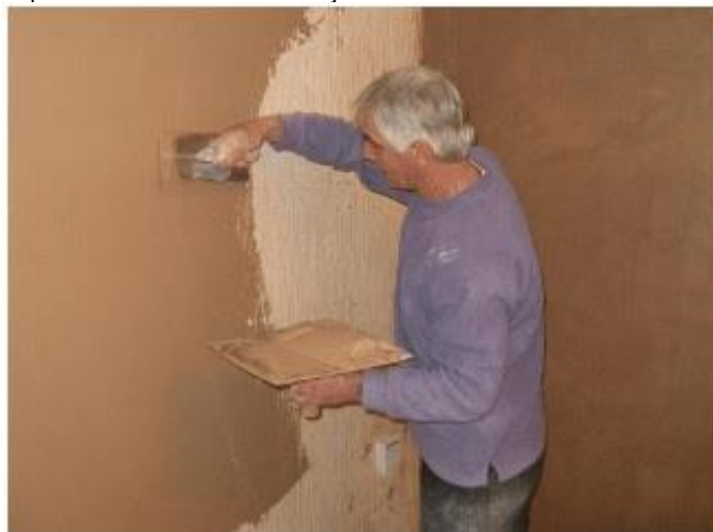
Um artesão rebocando uma parede (este trabalho foi realizado em domínio público pelo seu autor. Arpingstone )
