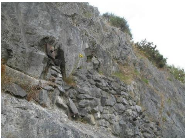
Figura 5. Proteções de rocha e redes sendo utilizadas para estabilizar rochas em uma encosta em A5 Ty Nant Cutting, North Wales.
