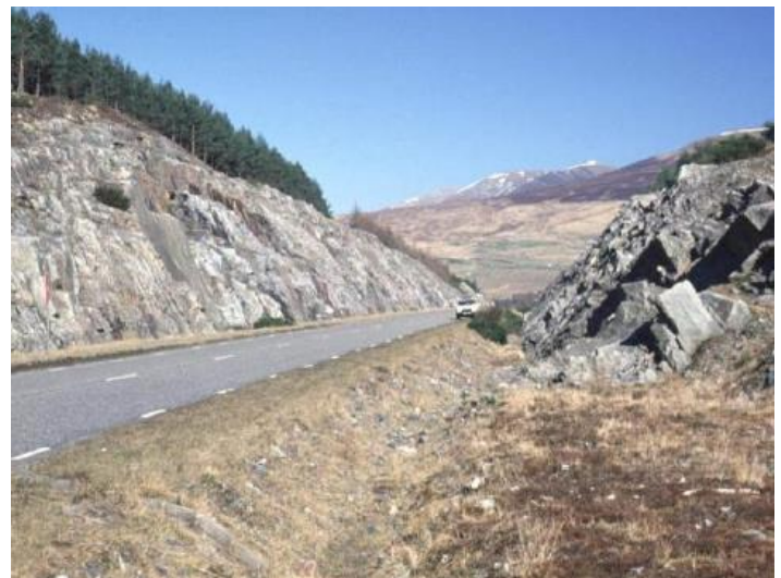
Figura 4. Uma estrada cortando rochas que estão inclinadas da direita para a esquerda. As rochas à direita poderiam facilmente deslizar do plano do acamamento, mas as rochas da esquerda estão relativamente estáveis por estarem inclinadas dentro da encosta.
