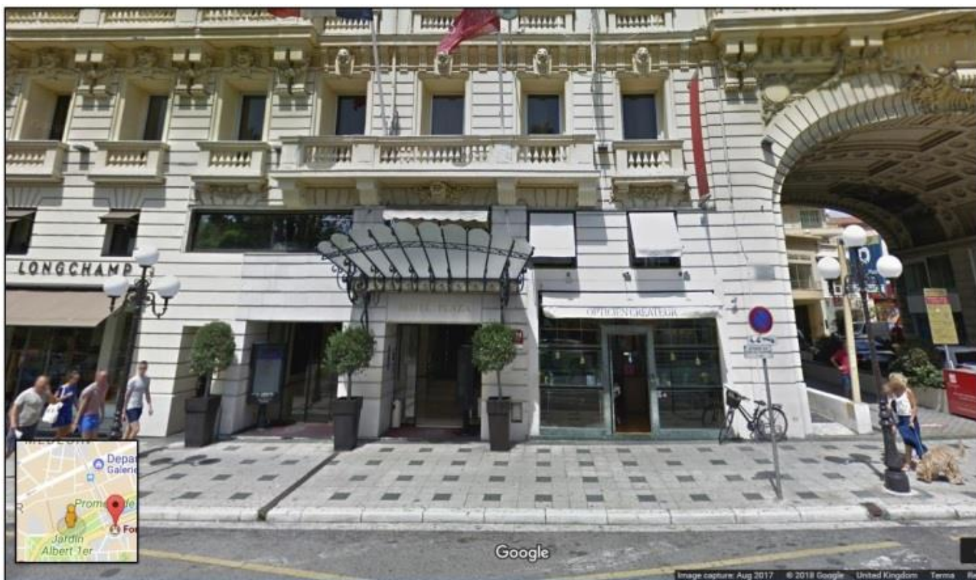
Rochas ornamentais usadas para adicionar interesse a um pavimento, hotel e frentes de loja em Nice, França. (Vista de rua do Google Maps)
