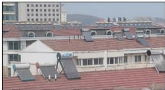
Painéis solares de água quente na província de Weihai, Shandong, China.
