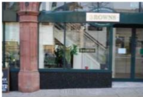
Rochas de construção no centro da cidade - arenito vermelho e 'granito' compõem a frente do café, enquanto granitos e arenitos amarelos formam a pavimentação. St Paul's Parade, Sheffield (Foto: Peter Kennett).
