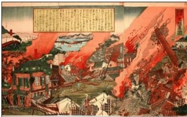
Cidade de Gifu destruída pelo terremoto Mino-Owari em 1891 Utagawa Kuniyoshi (1847-1899)
