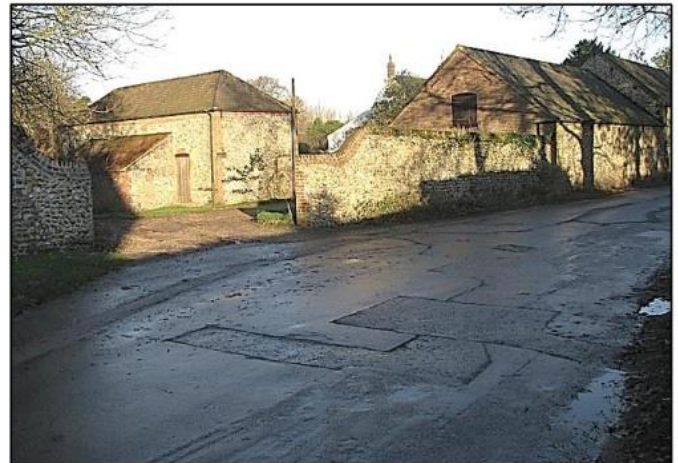
Estrada remendada fora de uma casa de fazenda - qual o asfalto foi colocado primeiro?
